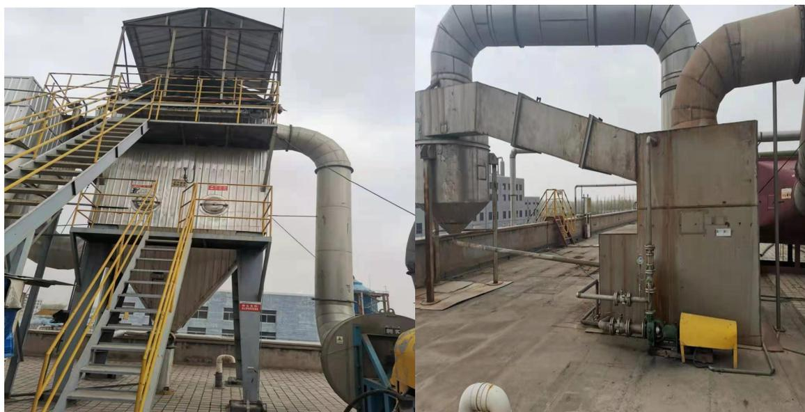
图 6-2 项目布袋除尘器+旋风除尘器
