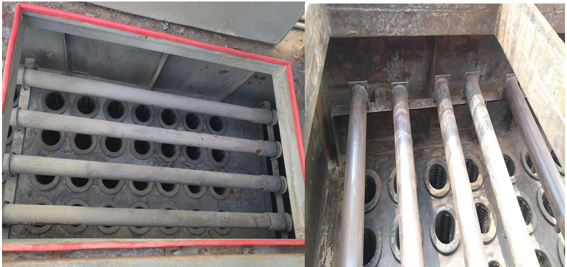
项目布袋除尘器内部改造
