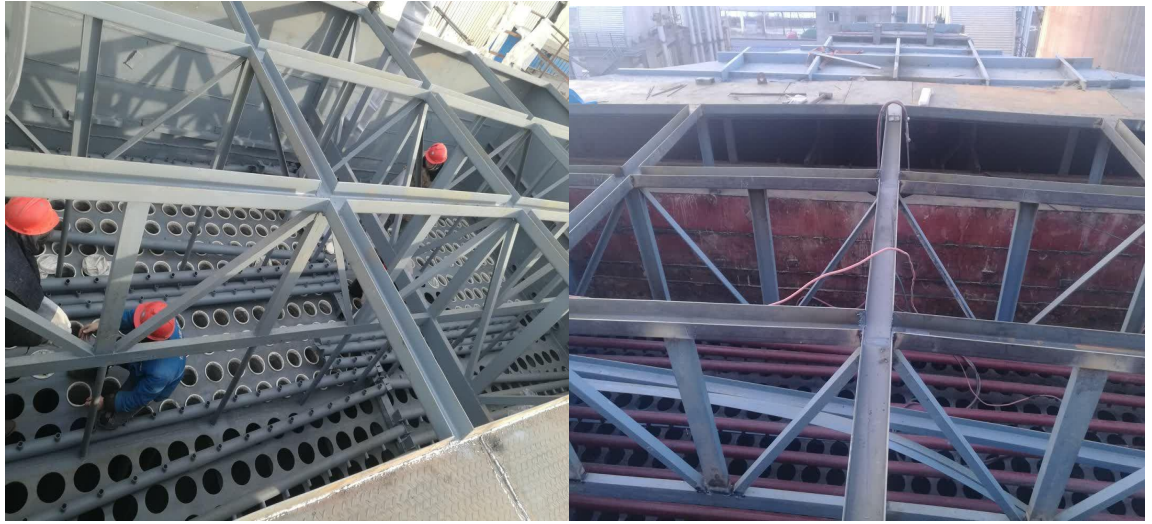
项目布袋改静电施工中
